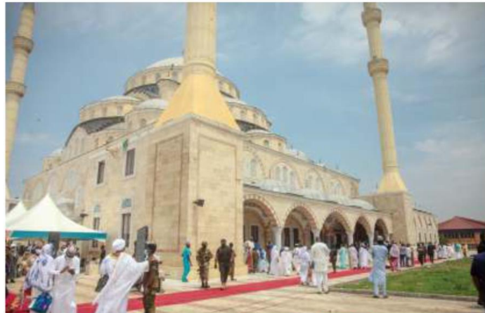
Gana'nın başşehri Akra'da Müslümanların yoğun bulunduğu Kanda mahallesinde, Türkiye Diyanet Vakfı ve Aziz Mahmut Hüdayi Vakfı'nın desteğiyle yaptırılan Millet Camii ve Külliyesi'nin açılışı gerçekleştirildi. Fotoğraf: İNANÇ CEYLAN - aa
