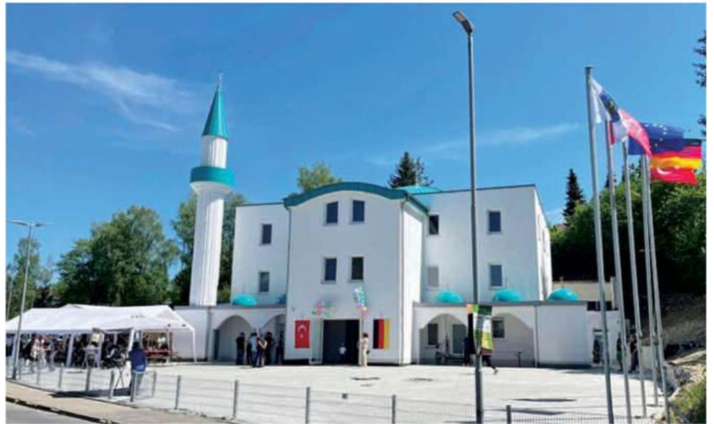
4 bin 700 metrekare alan üzerine inşa edilen camii , yaklaşık 400 metrekare ibadet alanına sahip. 20 metre uzunluğunda tek minaresi, bir ana kubbe ve
