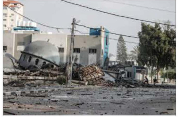
mamen, 200'ünü ise kısmen yıkan İsrail, 3 kiliseyi hedef alarak yıkımına neden oldu. Ayrıca çok sayıda sivil yerleşim yerini kasıtlı hedef alarak yıkan İsrail, 2,3 milyon Filistinliyi Fotoğraf: ANADOLU AJANSI
